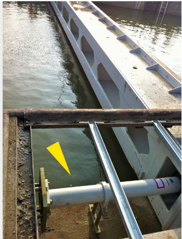
Speziell für diesen Einsatzfall ausgelegte schwere Sicherheitsstoßdämpfer bremsen in Schleuse Massen von bis zu vier Millionen kg ab
